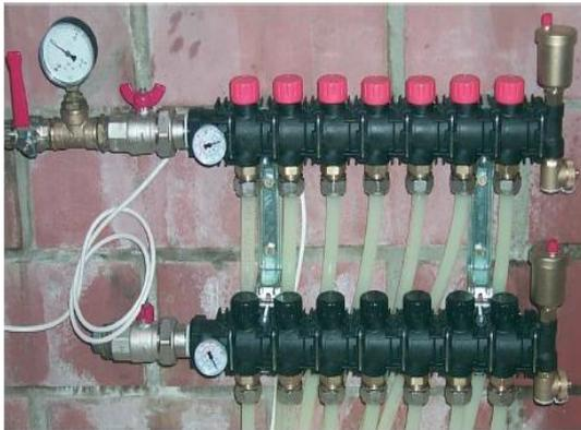
Durante la colocación de la losa de mortero, hay que mantener la presión en los tubos, para que el tubo tenga espacio para la dilatación.
