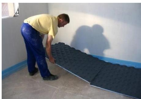
Para el aislamiento del suelo se utilizan paneles de poliestireno expandido. Los paneles son termoconformados con tetones, que además de proporcionar el aislamiento térmico y acústico necesario, sujetan y fijan la tubería emisora, guiándola y facilitando el trazado de los circuitos con la separación entre tubos proyectada.
