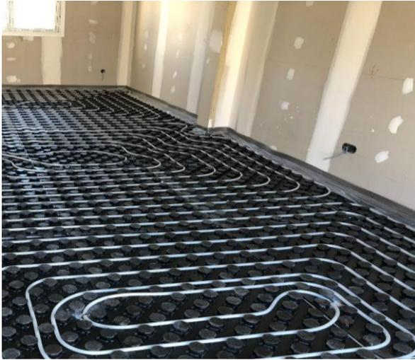
11. La altura aconsejable de la capa de mortero por encima de la generatriz superior de los tubos es de 45 mm. El vertido del mortero se hará en sentido longitudinal de los tubos.
