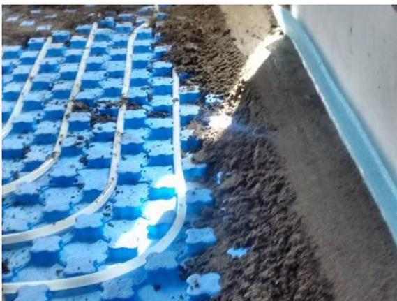
Una vez instalados y probados los circuitos hidráulicos de los tubos, se procederá al vertido del mortero de cemento sobre la superficie calefactora. El espesor recomendable es 45 mm. (aunque, los límites del espesor están comprendidos entre 30 mm. y 70 mm), medidos encima de la tubería.
