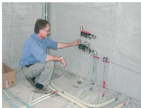
El primer paso que se debe dar para montar una calefacción de suelo radiante es situar los colectores, porque de ellos parten los rollos de tubo que se repartirán por los distintos circuitos. Fijar los colectores en el lugar acordado con el propietario de la obra o el responsable de esta. La ubicación de estos debe elegirse en base a los siguientes criterios:
