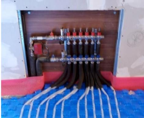
a. Se comienza el tendido partiendo del colector correspondiente, teniendo en cuenta que debemos prever margen suficiente para su posterior conexión al mismo. Un soporte para el tubo (desbobinadora) permite una colocación más rápida y limpia de los tubos sobre las placas.
