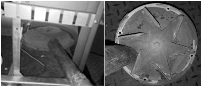
Limpeza de la carcasa y la turbina
