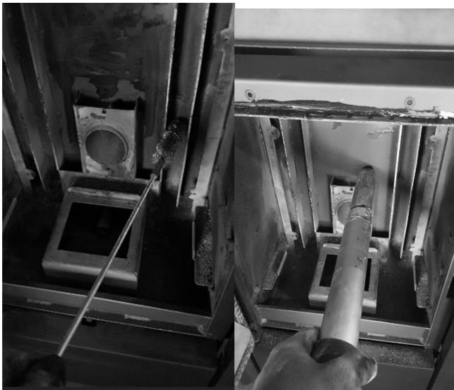
Limpieza de la cámara de combustión
