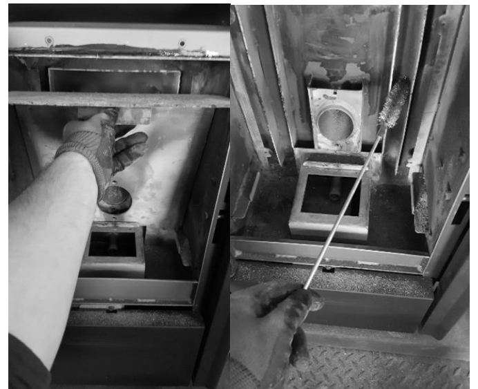
Retirada de la protección de los circuitos de humo.
