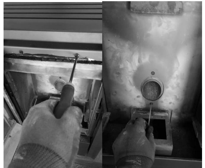
Retirada de la protección de los circuitos de humo.
