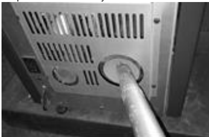
Limpeza del tubo de salida
