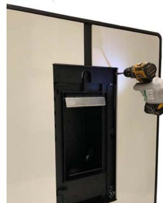
Fig. 41 - Fijación del revestimiento
