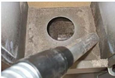
Fig. 71 - Limpieza alojamiento cajón de cenizas
