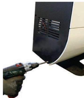
Fig. 33 - Fijación inferior de los paneles
