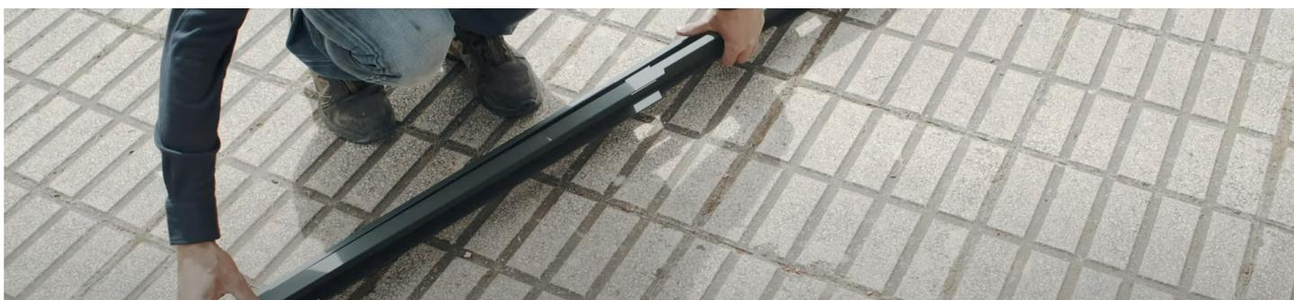
La pieza completa de "U" puede colocarse obrada con garras o atornillada directamente al pilar. Nos ayudamos de un nivel para ajustar la perfecta verticalidad de la "U". Los colisos permiten un último ajuste fino de la verticalidad.
