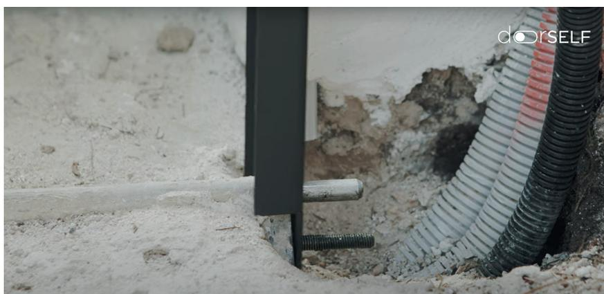
Atornillar la "U" de cierre con el tramo angular, teniendo en cuenta que una de sus caras va instalada al pilar. Poner el cajetín de la cerradura con los dos tornillos restantes.
