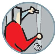
Pegar la cinta adhesiva de aluminio en la junta de las laminas Polynum
