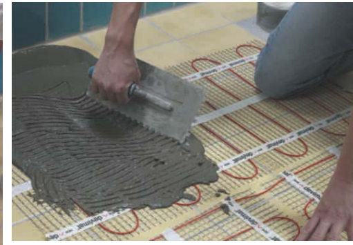
6 – Tapar con cemento cola/mortero
