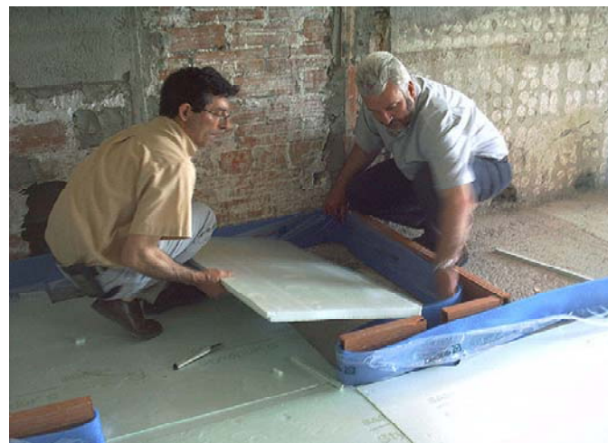
2 – Instalación del aislante base (opcional)
