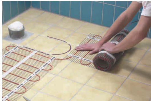
5 – Cortar para adaptar a la área
