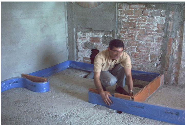
1 – Instalación de la banda perimetral
