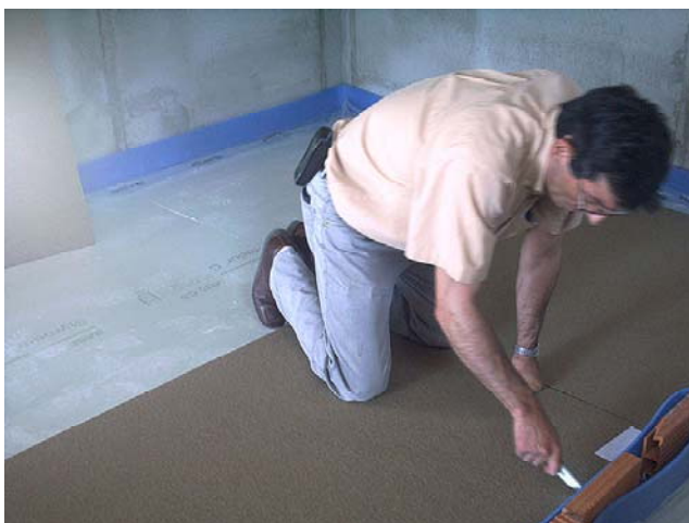
3 – Instalación de la placa base
