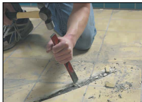
2 – Abrir la regleta para la sonda
